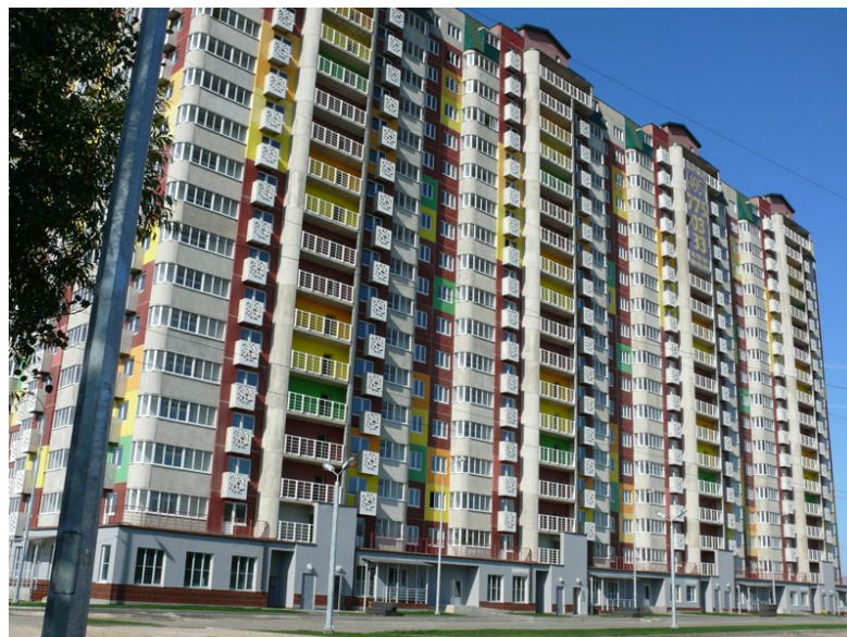
Строительство жилых корпусов в ж/к «Победа» в г. Лобня МО ул.Жирохова (ул.Горки Киевские) 2-я оч. стр-ва
